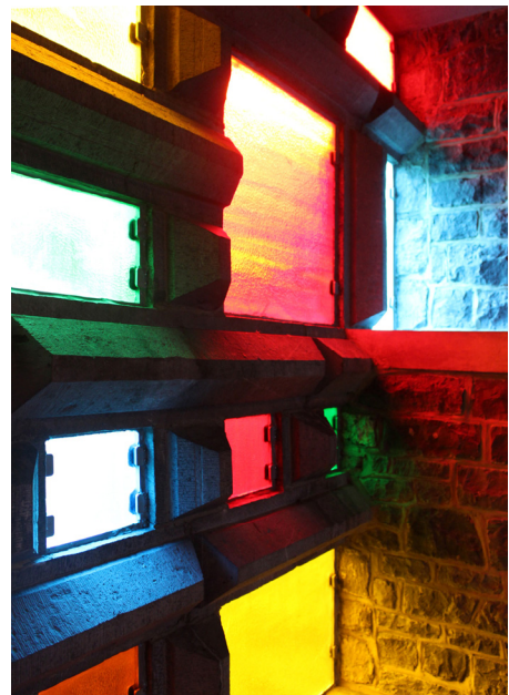
Fig. 5, 6, 7: voorzijde met hergebruikte roosvenster en klokkentoren; plattegrond met van onder naar boven de toegang, de liturgische ruimte en dienststruimtes; detail hergebruik gotische raamstijlen met glas in lood.
